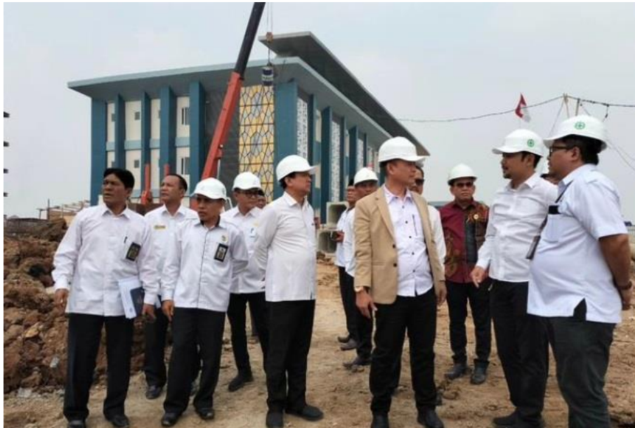
Gambar 3.69 Pembangunan Hotel Grand El Haji Asrama Haji Cipondoh
