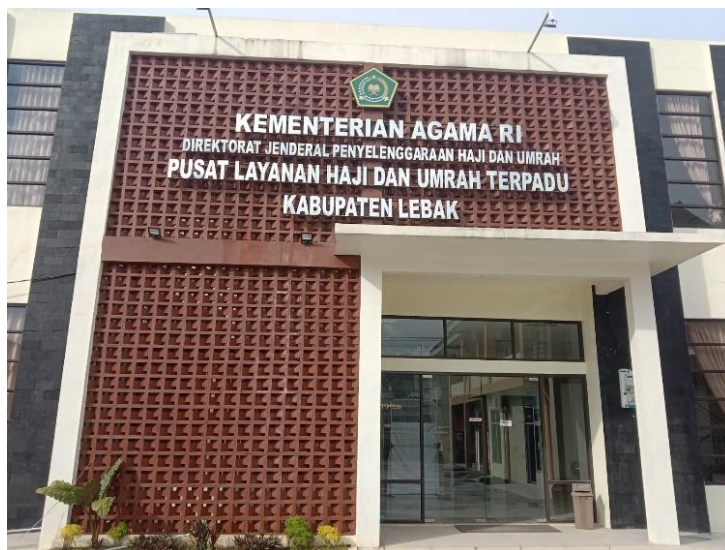
Gambar 3.63 PLHUT Kab. Lebak
